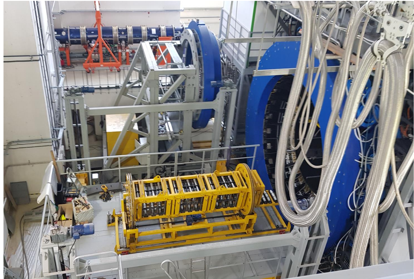
Процесс монтажа модулей Escal с подъемной платформы
