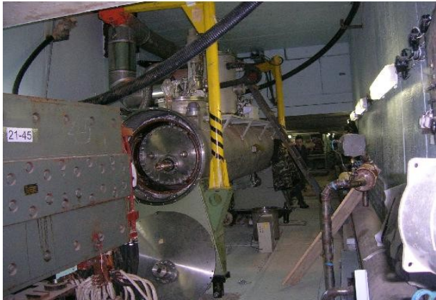
RF1 дефлектор в канале
